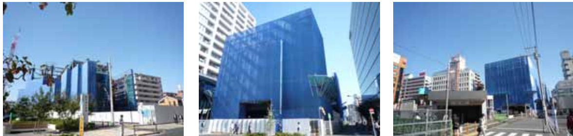
(再開発ビルの建設がすすむ調布駅前 H28. 10)
