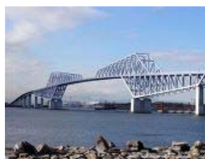
東京ゲートブリッジ
